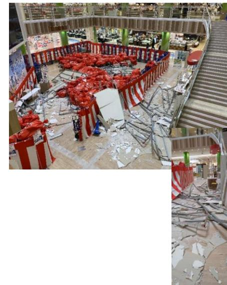
天井の飾り柱13本の内 7本が落下（鉄骨の柱がむき出し状態になった）
