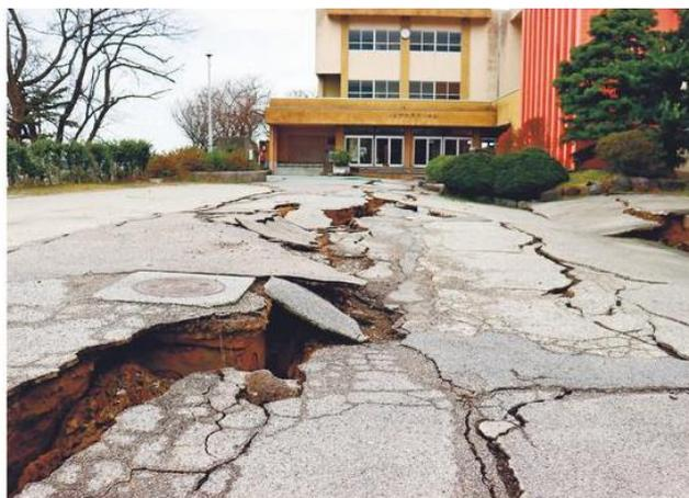
1日に震度5強を観測した氷見市島尾の宮田小学校で、地面のひび割れや陥没などが多数見つかった。3日は自治会役員が現場を訪れて被害状況を確認した。正門前のコンクリートに長い亀裂が入り、地面がむき出しになっているほか、校舎につながる坂道が崩れ、車の進入が難しい状況だ。市教育委員会によると、市内のほかの学校で宮田小のような大きな被害は出ていないという。
