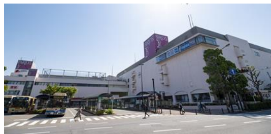
新生港南台バース外観
