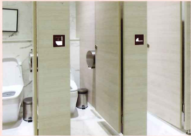
トイレ内の各ブース
