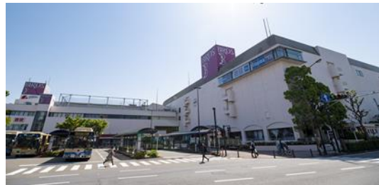
新生港南台バース外観
