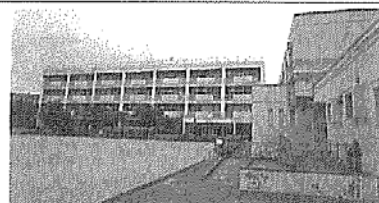
市内全域が都市ガス供給エリアながら、LPガスを採用(箕面小学校)
